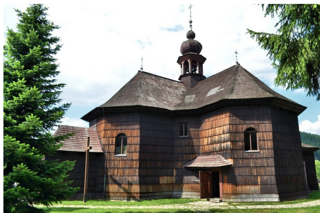
Obr. 17 Kostel Panny Marie Sněžné ve Velkých Karlovicích (Kostel Velké Karlovice)
