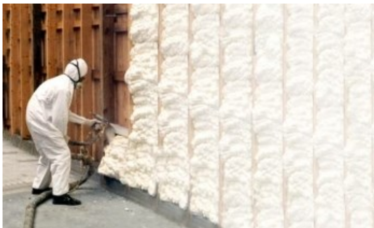
Obr. 19: Tepelná izolace z PUR pěny [38]
