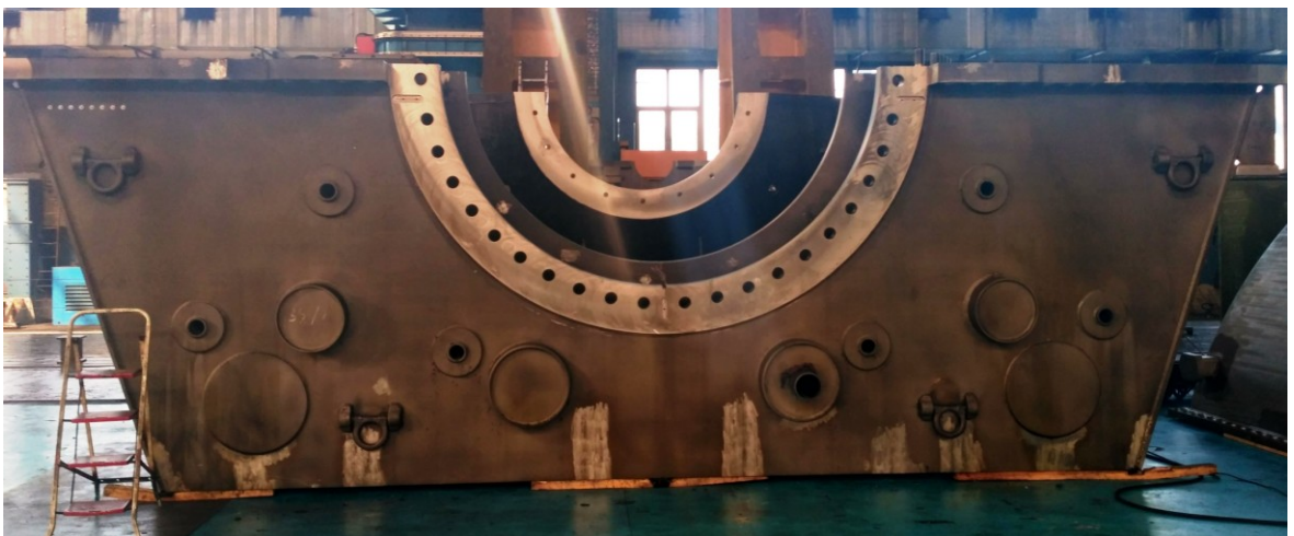
Obr. 37. Spodní díl radiálního výstupního hrdla po opravování
