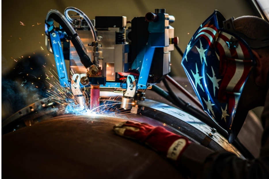
Obr. 15. Ukázka mechanizovaného obloukového svařování [17]
