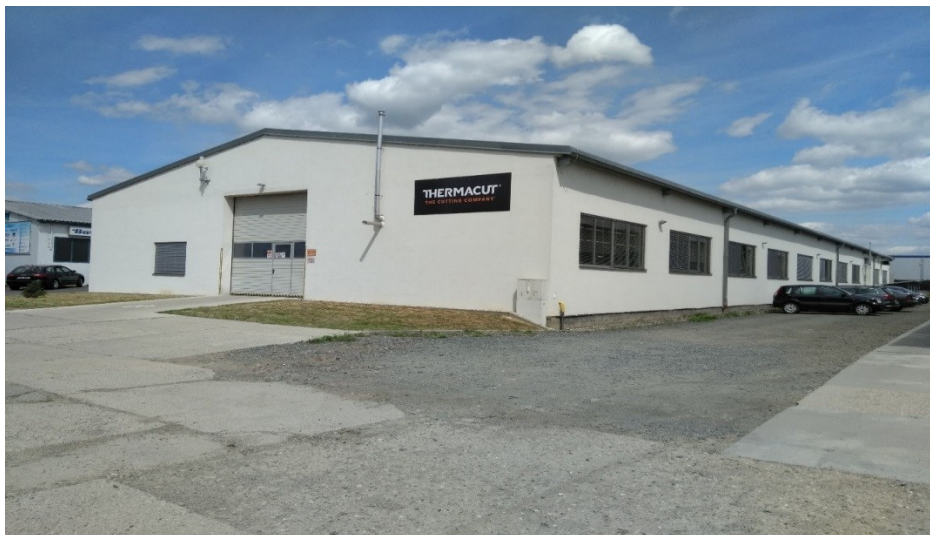
Obr. 9 Výrobní a skladovací hala – Thermacut, k.s. [zdroj vlastní]
