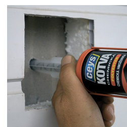
Obr. 54: Použití chemické kotvy.
