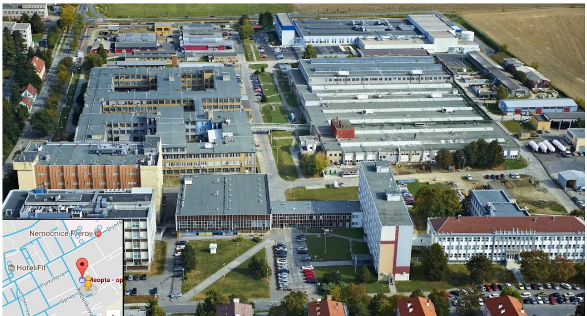
Obr. 17: Pohľad na celý komplex Meopta – optika s.r.o.
