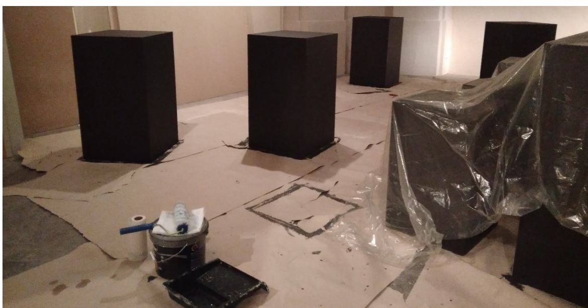
Obr. 49. Sokly opatřené nátěrem
