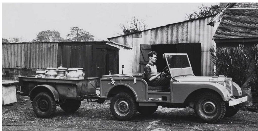
Obr. 4. První prototyp Land Roveru zvaný „centre steer“ [8]
