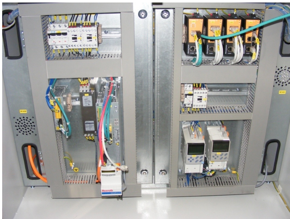
Obr. 54. Rozmístění ovládacích prvků v přední části rozvaděče
