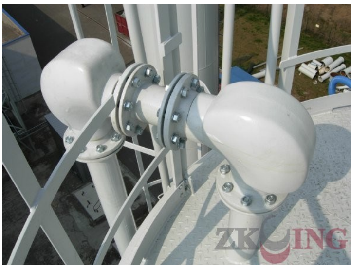
Obr. 6. 90° otěruvzdorné koleno [3]
