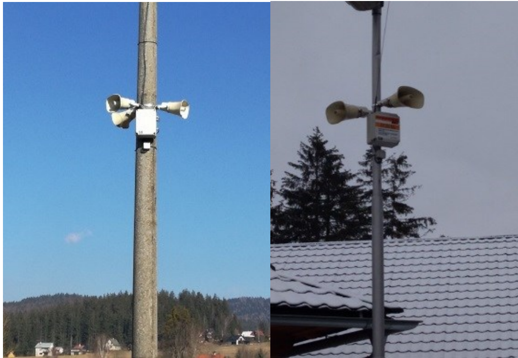
Obrázek 20 – Koncové prvky na sloupu nízkého napětí a veřejném osvětlení
