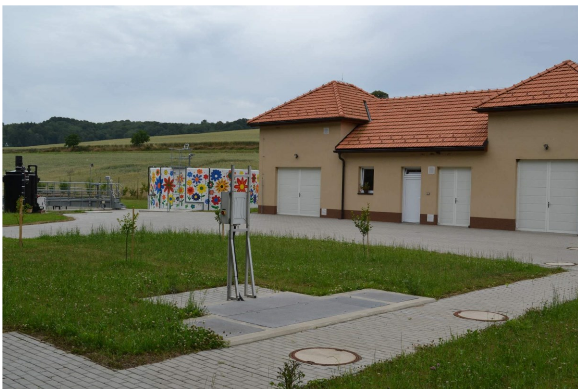
Foto příloha 8 – ČOV Halenkovice
