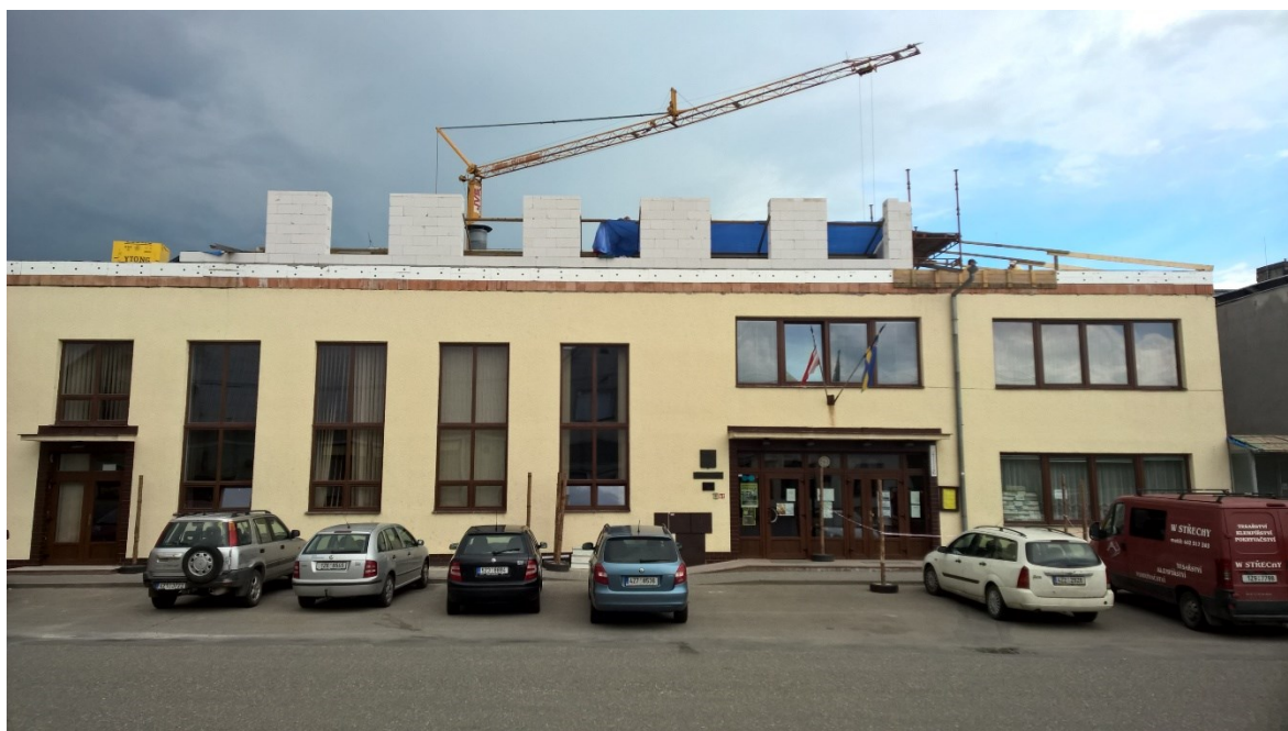
Foto příloha 2 Probíhající rekonstrukce OÚ – výstavba podkrovní části
