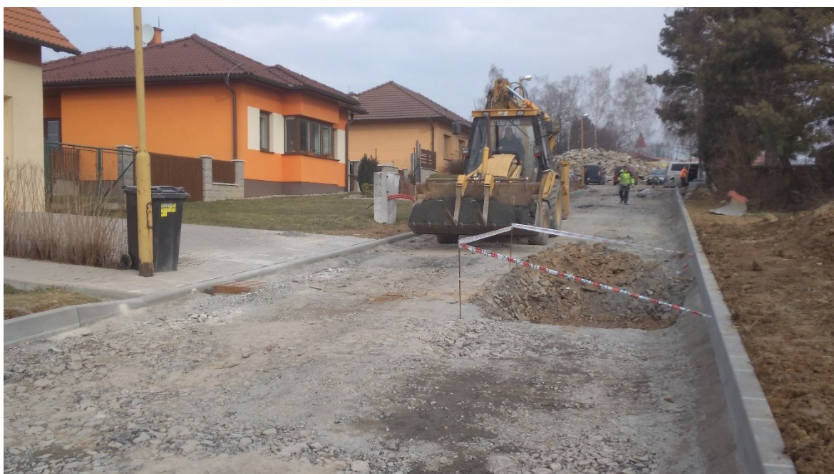
Foto příloha 6 - Rekonstrukce silnice v místní části Záhumení
