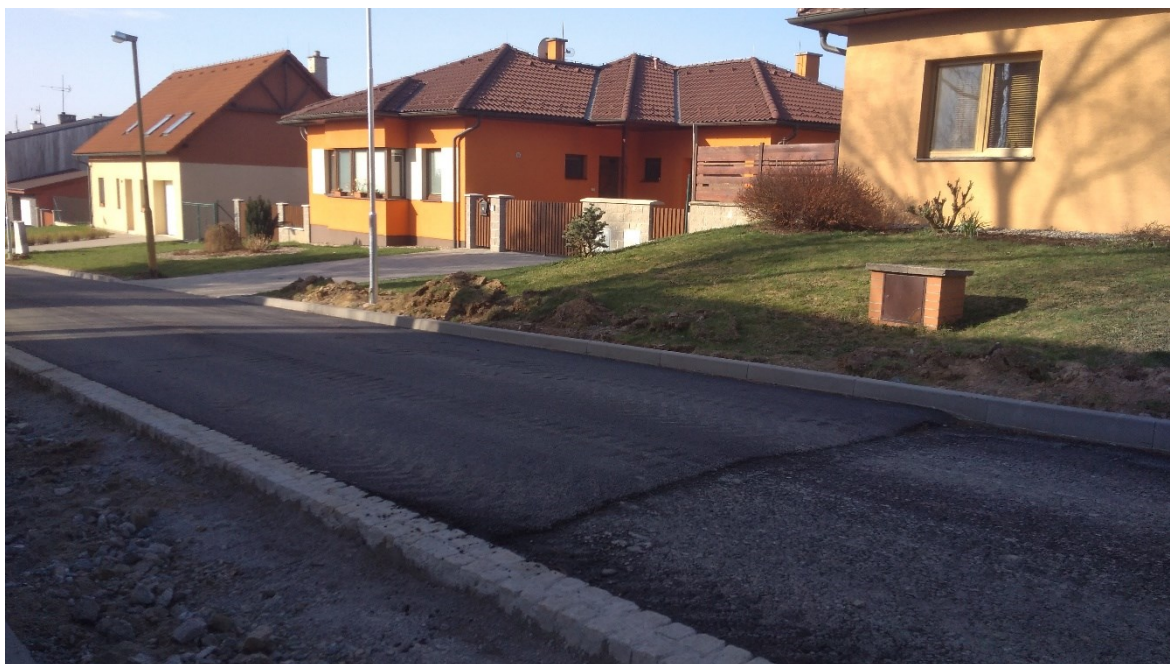
Foto příloha 7 - Silnice na Záhumení těsně před dokončením
