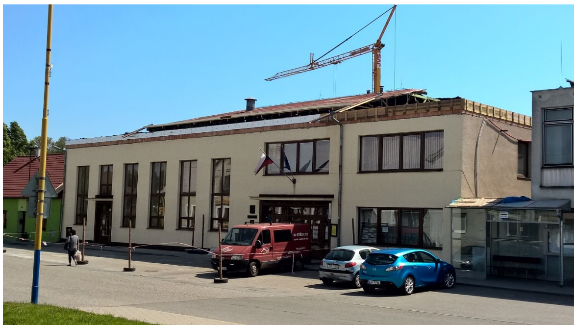
Foto příloha 1 – Rekonstrukce OÚ – sundávání staré střechy
