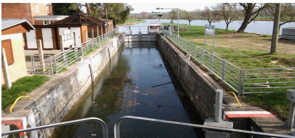
Obrázek 12 Plavební komora Spytihněv [Zdroj: autor]
