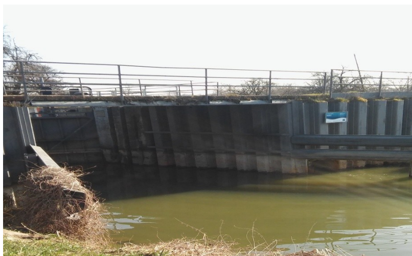
Obrázek 13 Plavební komora Babice [Zdroj: autor]
