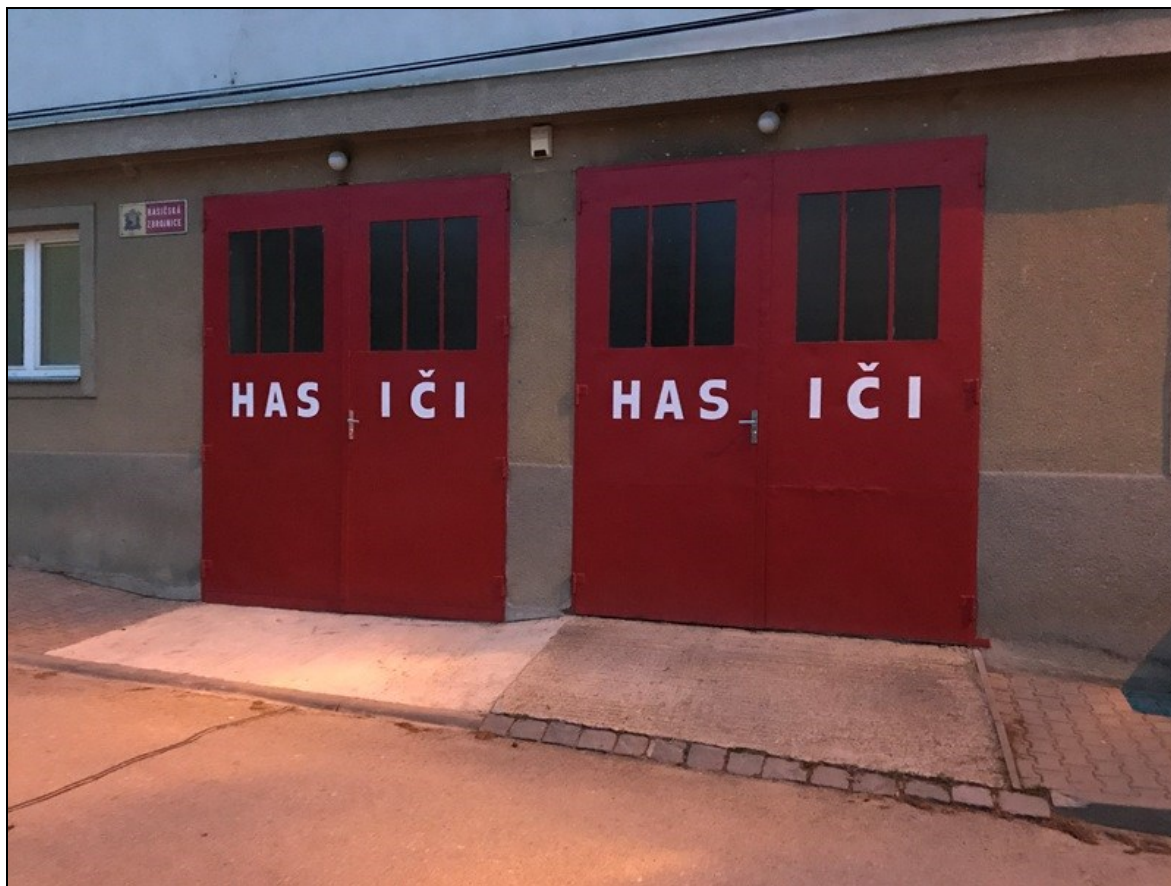
Obrázek IV. Hasičská zbrojnice JSDH Švábenice [Zdroj: vlastní]
