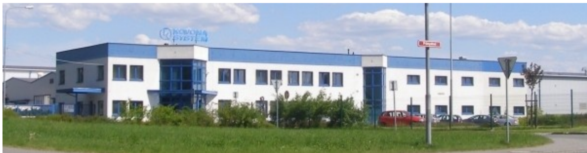
Obr. 6. KOVONA SYSTEM v současnosti. [26]
