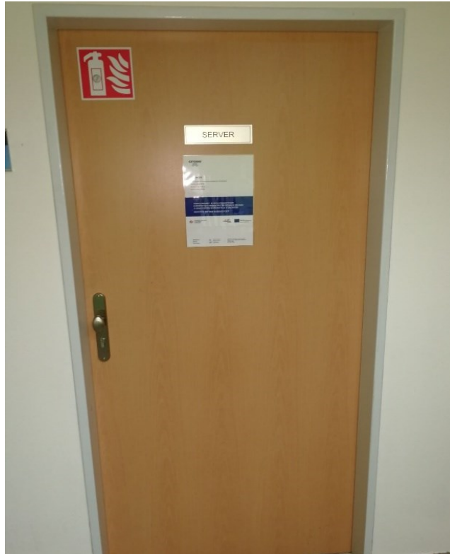
Obr. 11. Vstupní dveře do serverovny [25]
