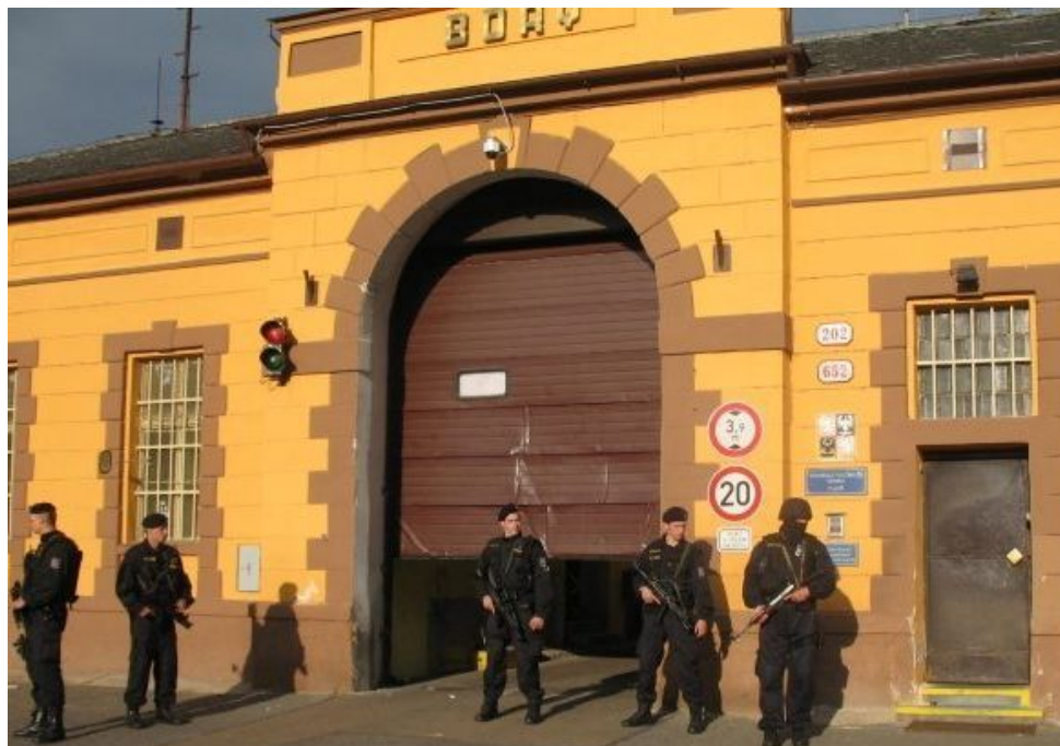
Obr. 3. Poškozená vjezdová vrata – Věznice Plzeň. [7]
