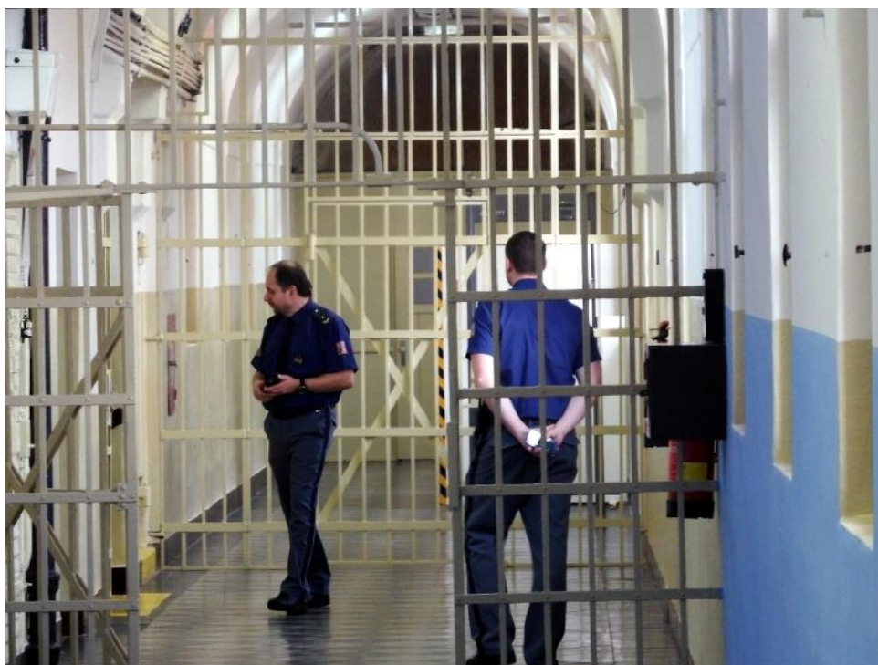
Obr. 22. Katrové dveře v ubytovacím objektu věznice. [28]
