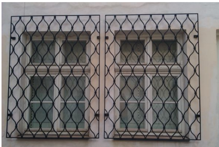
Obr. 21. Zabezpečení oken mřížemi. [27]
