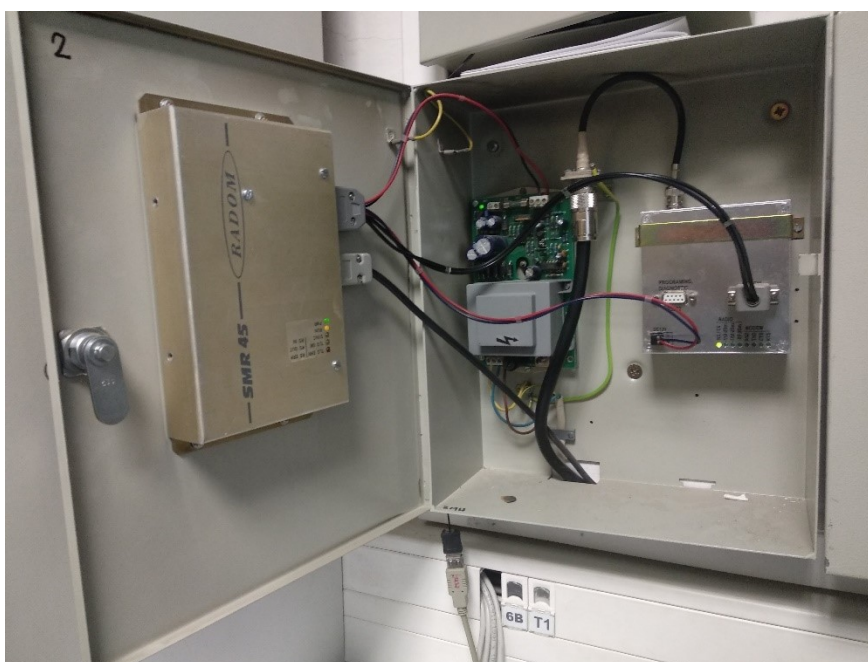
Obr. 12: Rádiový přijímač SRX10/400, zdroj autor
