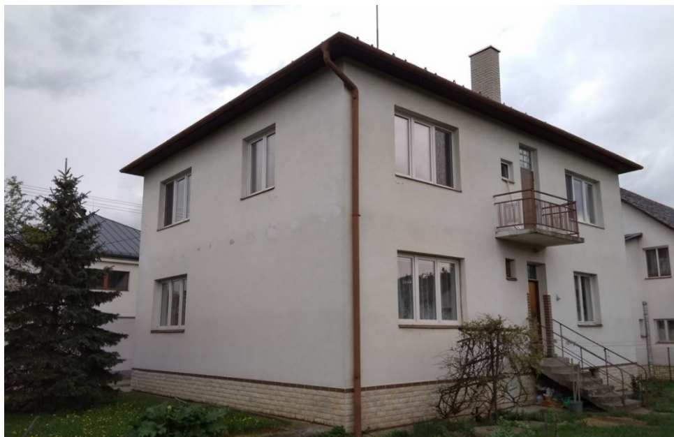
Obrázek 16 – Pohled na dům z jihozápadní strany
