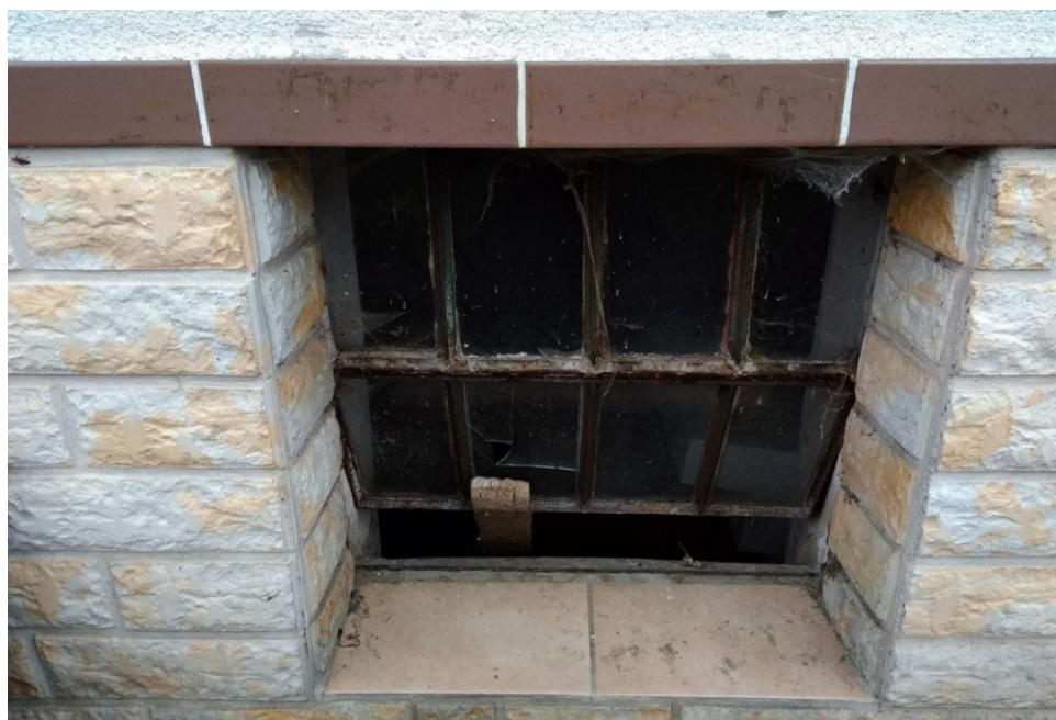
Obrázek 17 – Okno do sklepa
