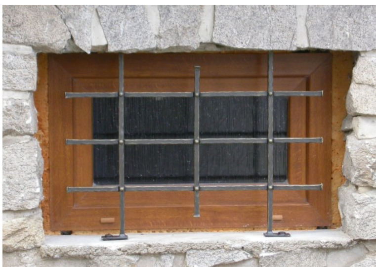
Obrázek 13 – Okrasná mříž na ochranu sklepního okna [28]
