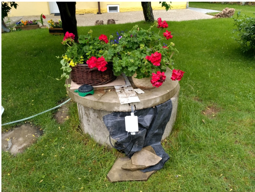
Obr. 17. Fotografie vrtu s instalovaným hladinoměrem a čidlem
