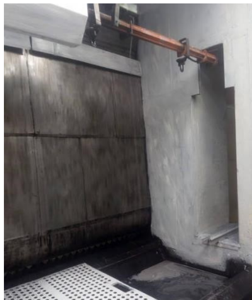
Obr. 20. Splachová stěna po provedení čištění (vlastní zpracování)
