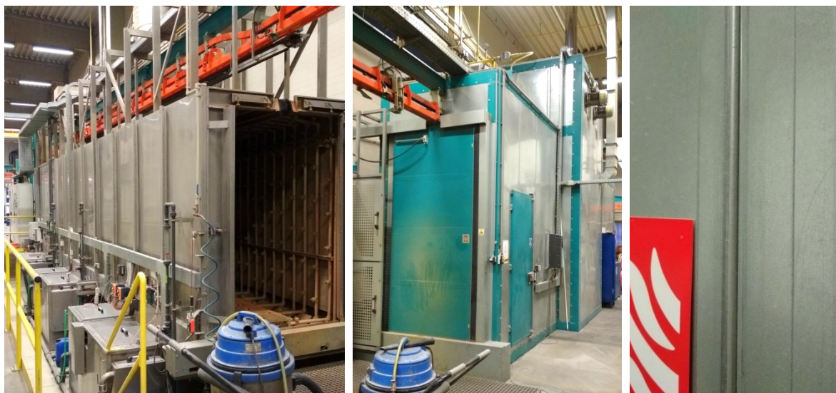
Obr. 57. "Sprcha" a sušárna (vpravo – povrch stěny sušárny)
