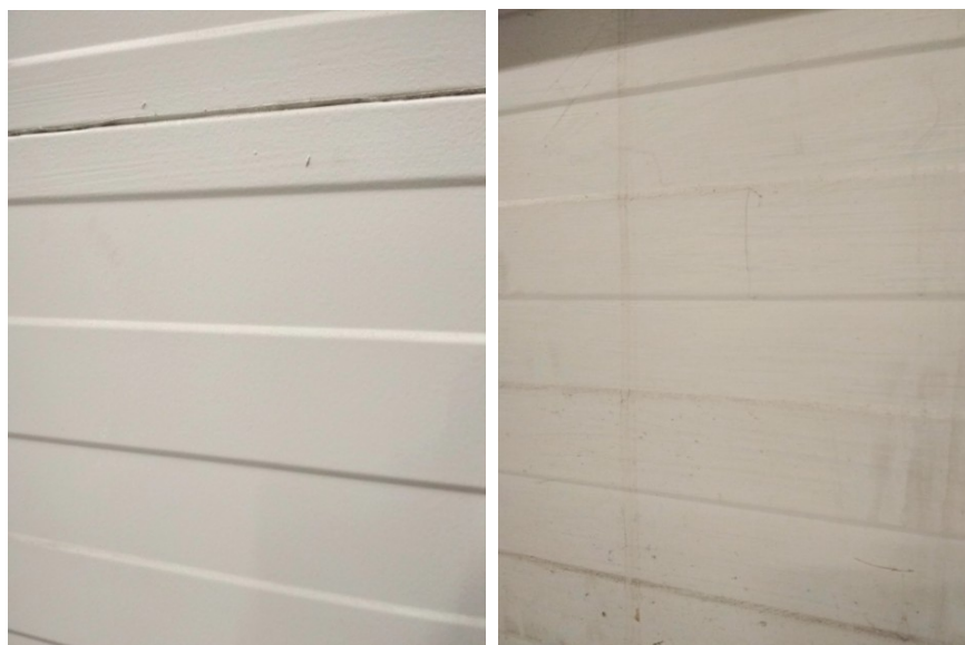
Obr. 53. Povrch stěn (vlevo – východní stěna, vpravo – jižní stěna)
