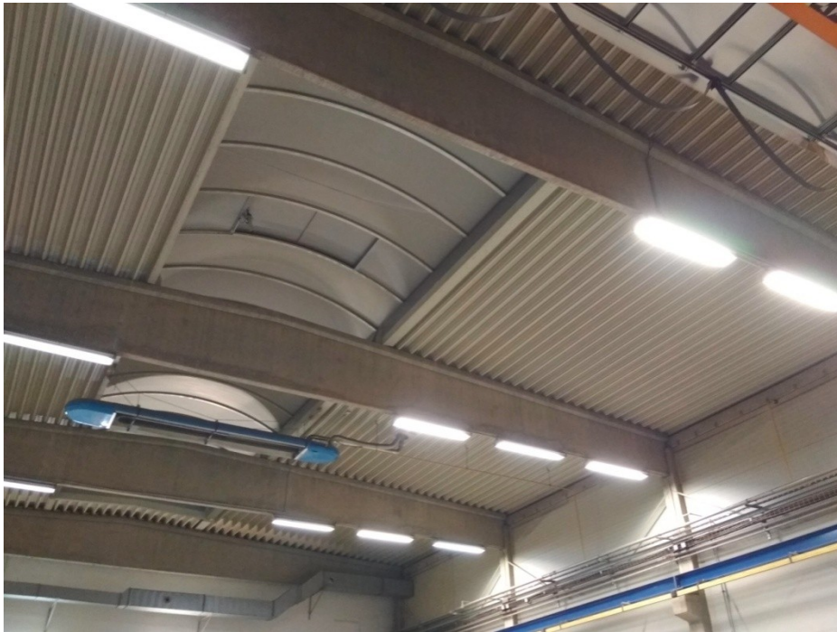
Obr. 30. Pohled na podélné světlíky během nočního měření
