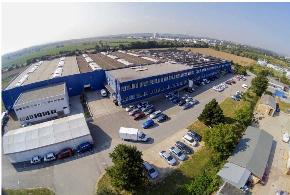
Obr. 25. Budova společnosti ESB Rozvaděče, a.s.
