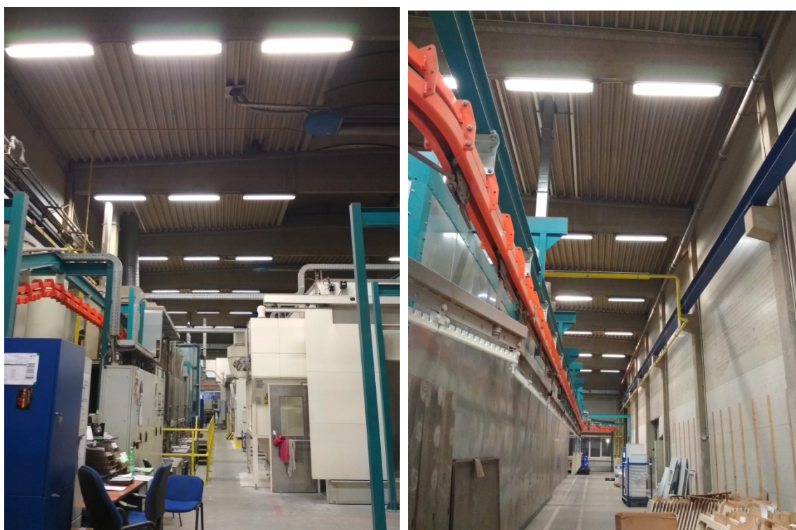
Obr. 29. Pohled na aktuální řešení osvětlovací soustavy (vlevo – východní strana lakovny, vpravo – západní strana lakovny)
