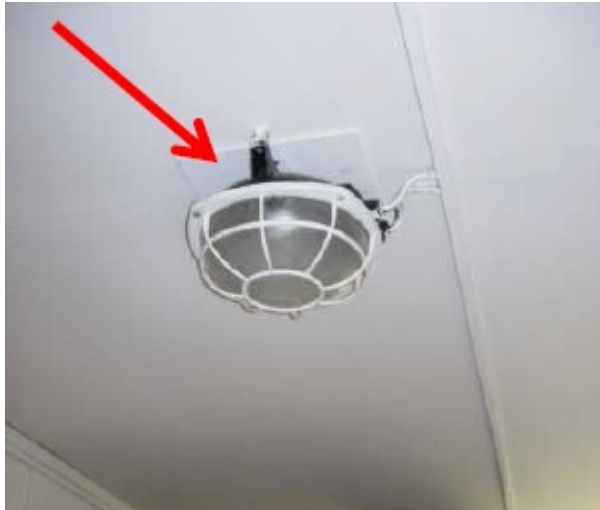
Obrázek 8 – Azbestové podložky pod osvětlením [23]
