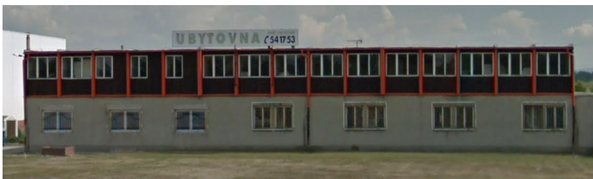
Obrázek 3 – Budova určená k demolici [vlastní zpracování]
