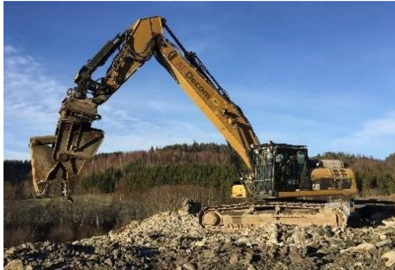
Obrázek 14 – Demoliční bagr s hydraulickými nůžkami [24]
