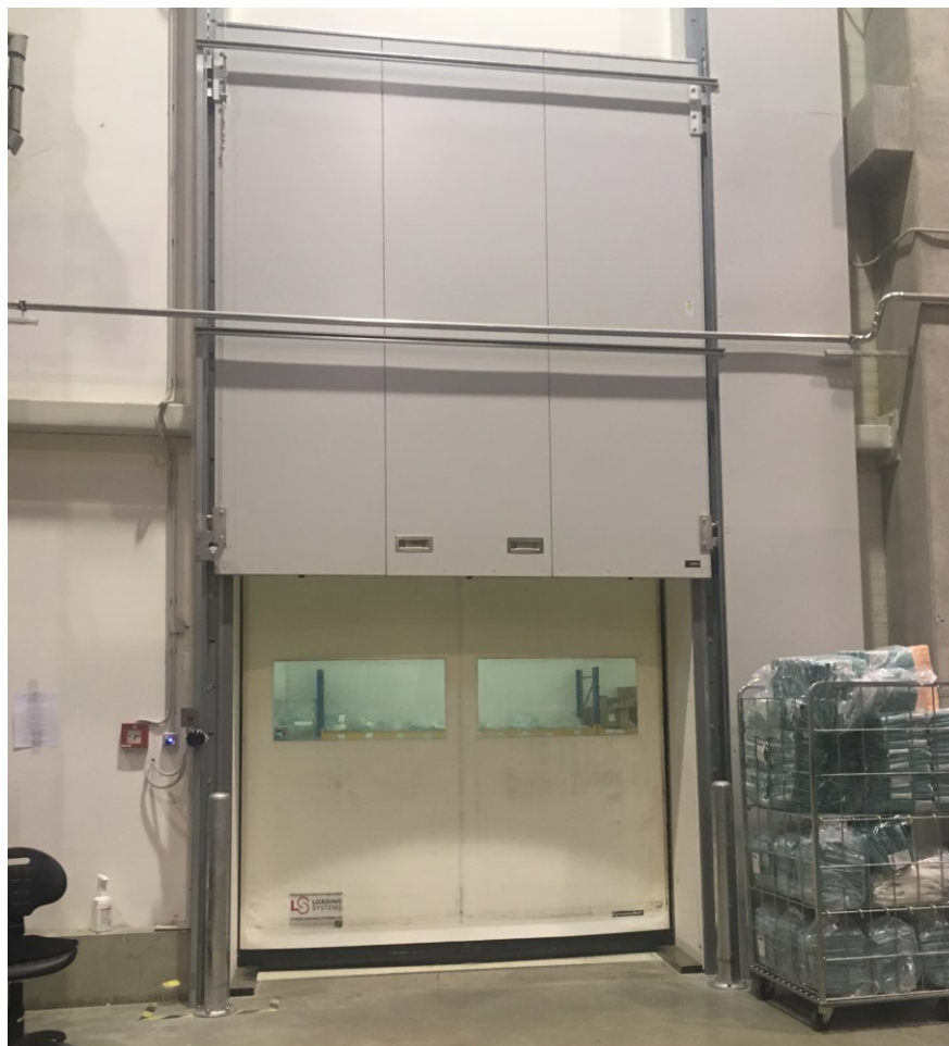
Obr. 14. Přechodová komora ze skladu do výroby [vlastní fotka]
