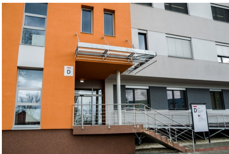
Budova D II.
