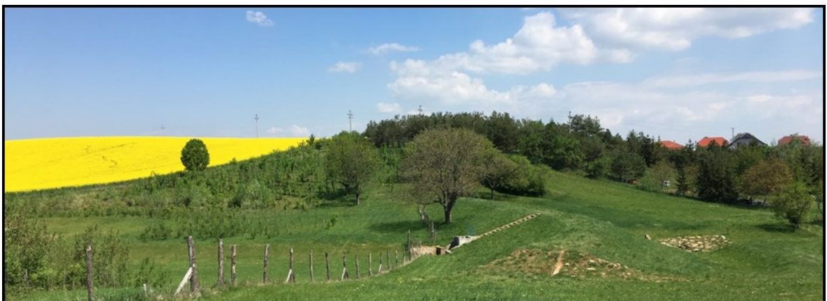
Obrázek 8 Panoramatický pohled na suchý poldr v obci [Vlastní]
