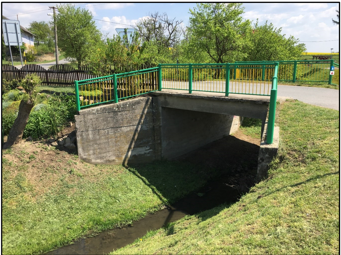
Obrázek 21 Most vedoucí přes Jankovický potok [Vlastní]
