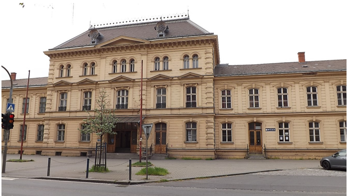
Obr. 14. Pohled na historickou budovu železniční stanice Přerov. [Zdroj: autor]
