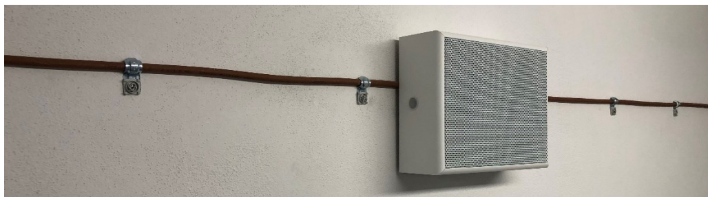
Obrázek 15 – Kabelová trasa systému EVR (archiv autora)
