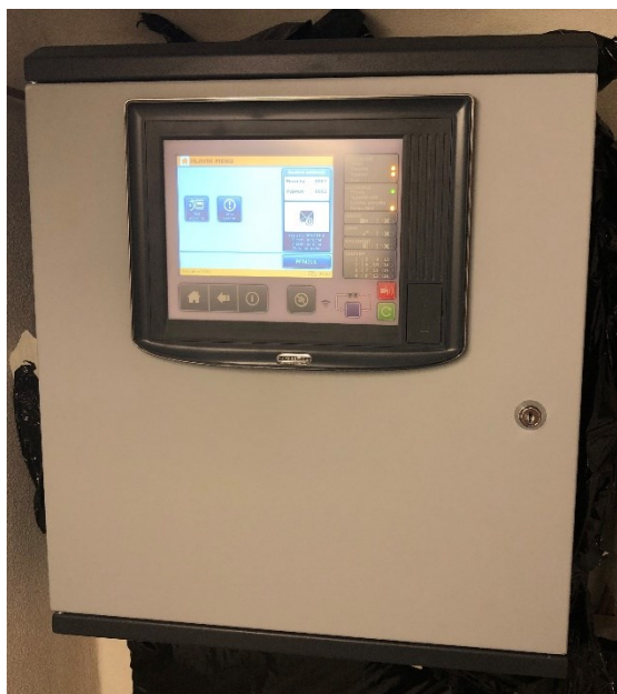
Obrázek 9 – Ústředna systému EPS Zettler PROFILE (archiv autora)
