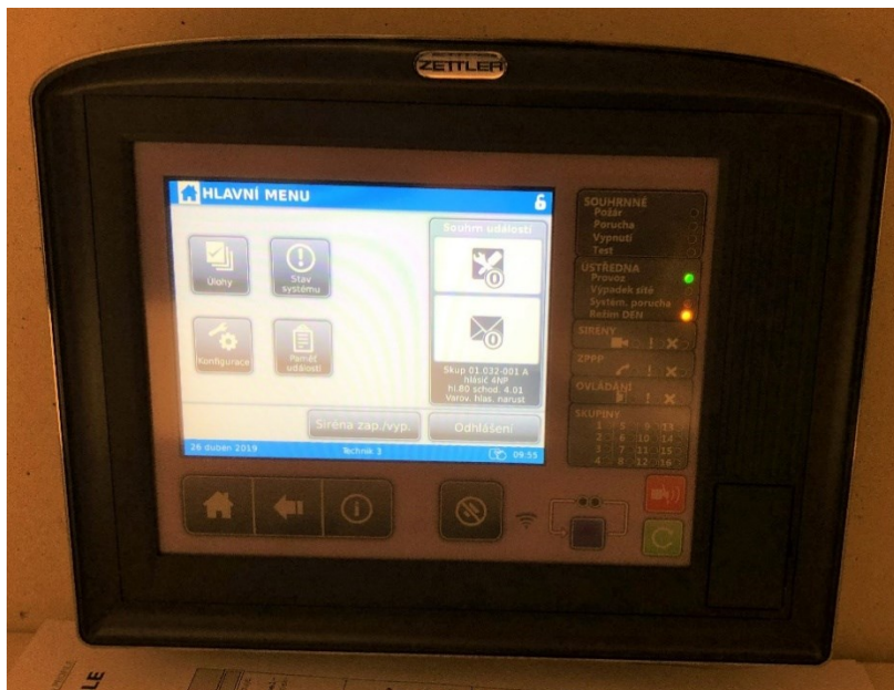
Obrázek 10 – Tablo systému EPS umístěné v ohlašovně požáru (archiv autora)
