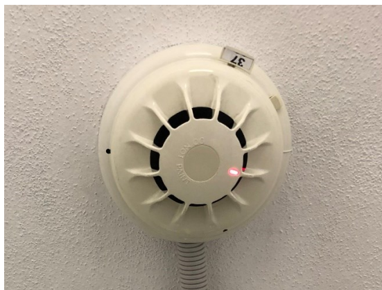
Obrázek 12 – Bodový hlásič 830P (archiv autora)
