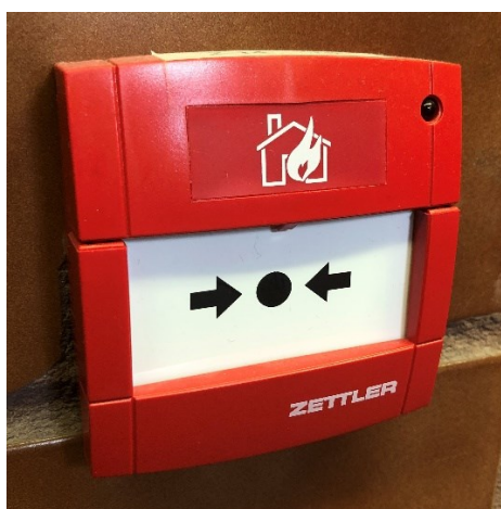
Obrázek 13 – Tlačítkový hlásič KAC MCP820 (archiv autora)
