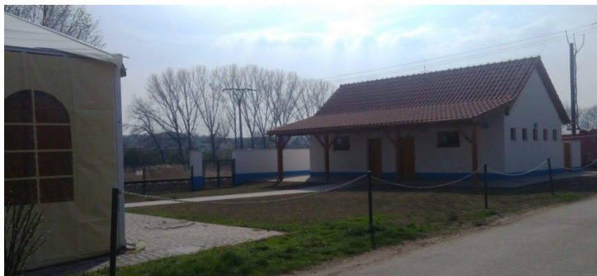
Obr. 18. Dokončené veřejné WC při areálu [vlastní]
