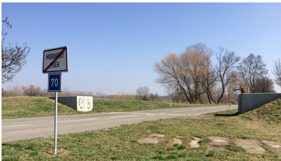
Obr. č. 21 – Zemní homogenní hráz v místě dělení na část A a B [vlastní]
