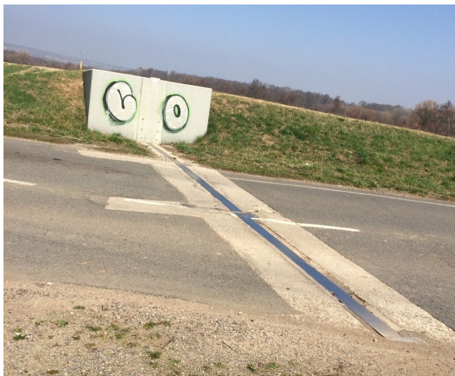
Obr. č. 27 – Místo, kde se instalují mobilní zábrany [vlastní]
