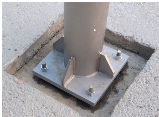
Obr.46: Chemické kotvenie v betónovej základni
