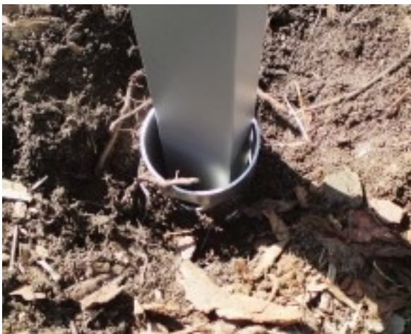
Obr. č. 25 Kotvenie mobiliára
