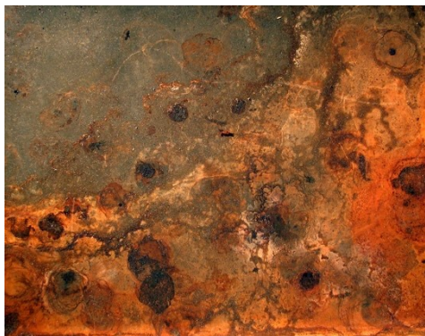
Obr. č. 1 Korózia kovového povrchu
