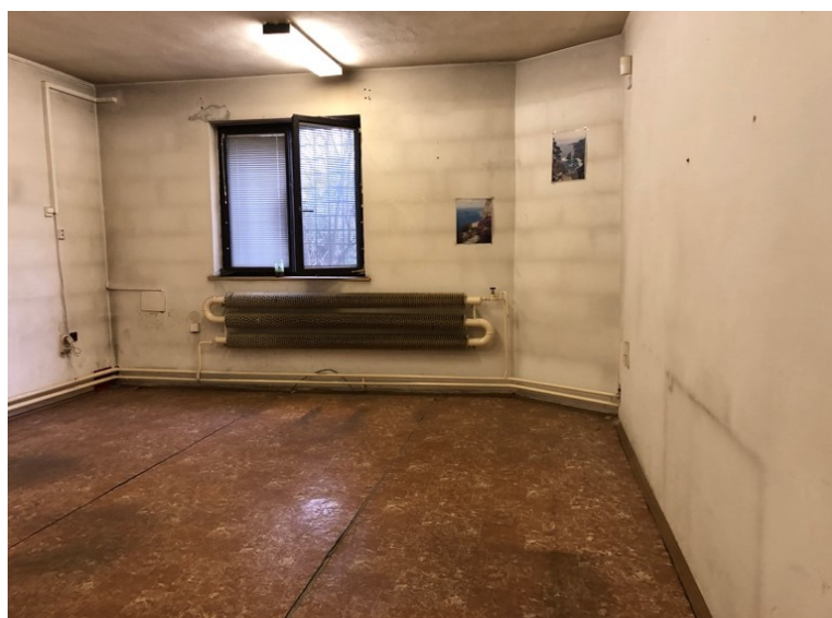
Obrázek 15: Kancelář před rekonstrukcí (Vlastní fotografie v ArcelorMittal)
