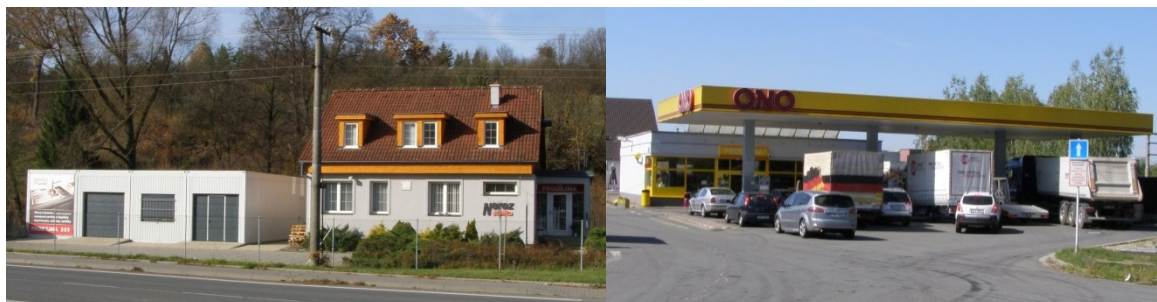
Obr. 27: Pohled na prodejnu společnosti NEREZ SANITA s. r. o. a na čerpací stanici ONO (vlastní foto)
