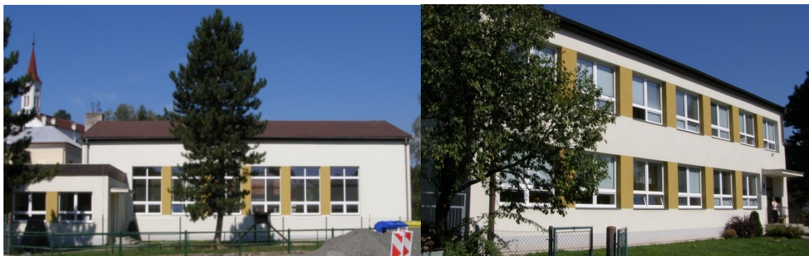
Obr. 16: Pohled na budovu tělocvičny a pohled na novou budovu školy (vlastní foto)
