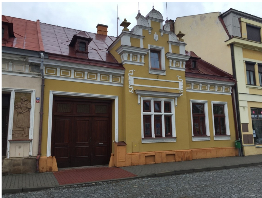
Příloha P II: Obrázek č. 4: Venkovní fasáda měšťanského domu čp. 1084 před rekonstrukcí
