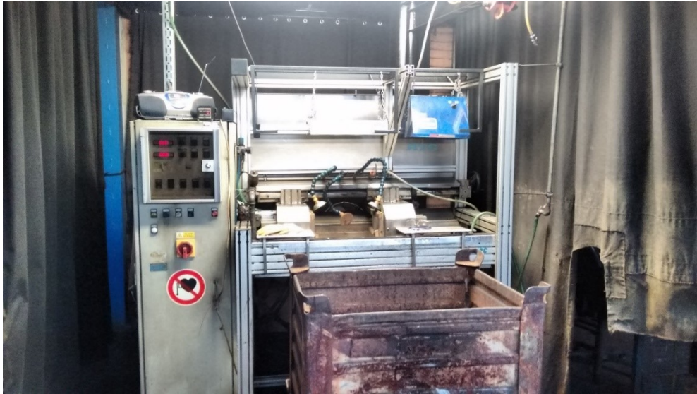
Obr. 20 Současný stav zařízení nedestruktivní defektoskopie
