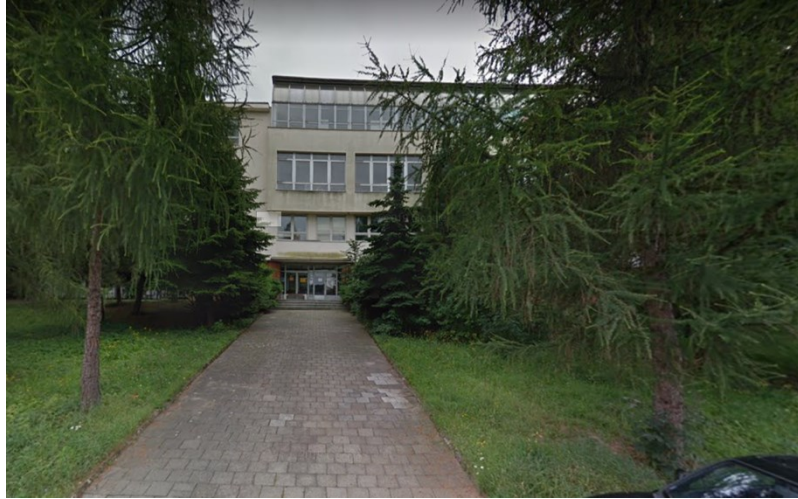
Obrázek 30 - Budova před rekonstrukcí v roce 2012
