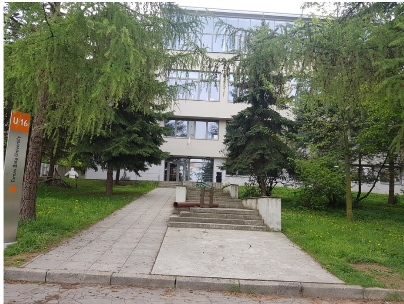
Obrázek 31 - Budova po rekonstrukci v roce 2012, foceno: 2019
