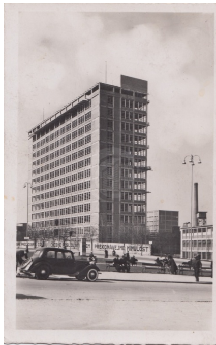
Obr. 2. Baťov mrakodrap, Budova 21.
