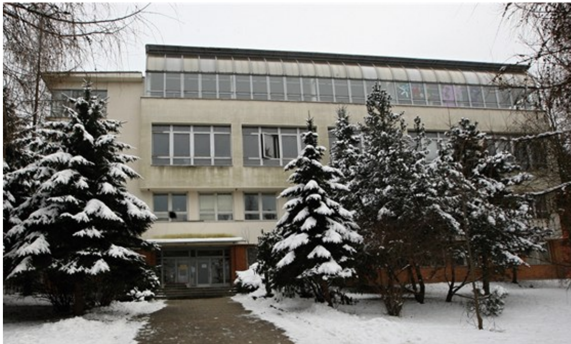
Obr. 4. Budova U16 pred rekonštrukciou
