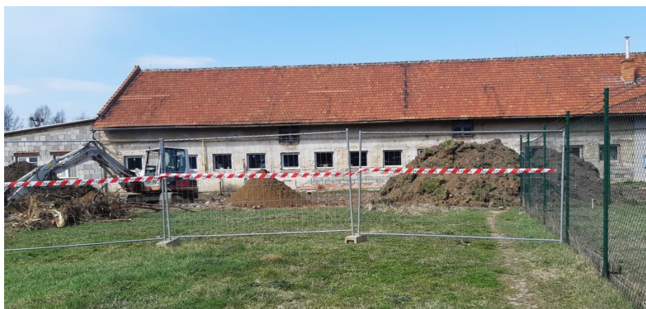
Obr. 3. Mobilní oplocení na staveništi [27]
