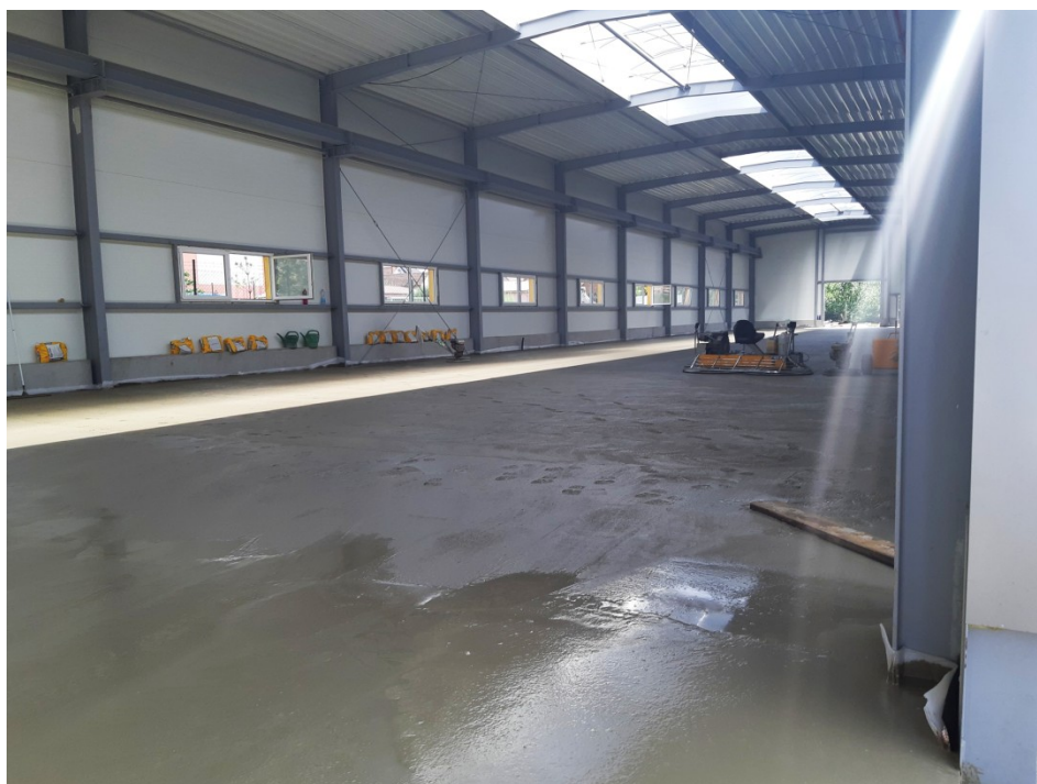
Obr. 11. Strojní hlazení podlahy [27]
