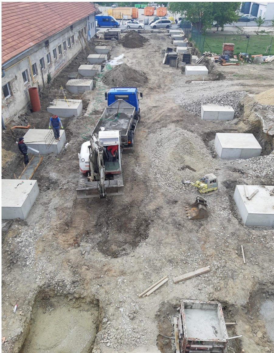
Obr. 5. Betonování základových patek [27]
