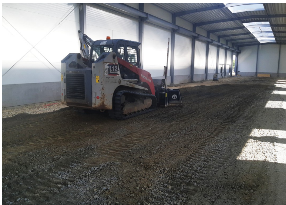
Obr. 9. Rozprostírání podkladních vrstev [27]
