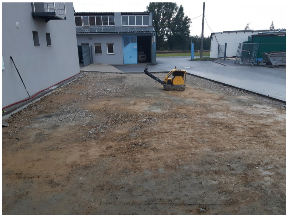
Obr. 13. Hutnění podkladních vrstev [27]
