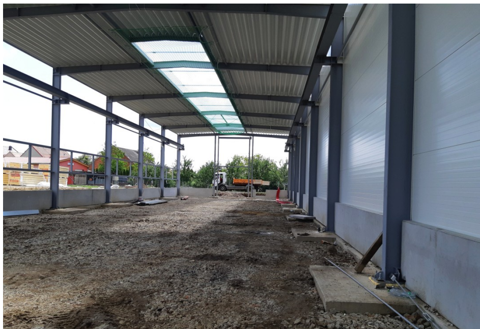
Obr. 7. Opláštění střechy a obvodových stěn [27]
