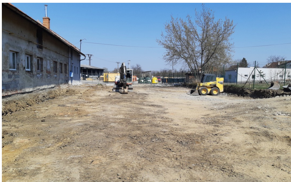
Obr. 4. Odstraněná vrchní vrstva zeminy v místě novostavby [27]
