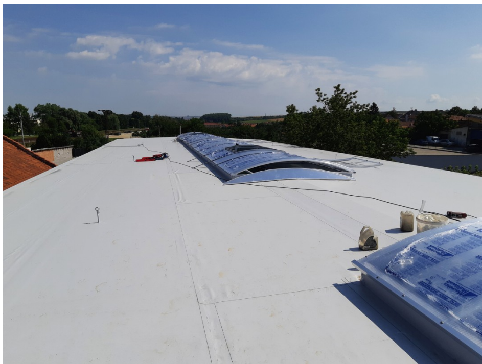
Obr. 8. Opláštění střechy a obloukový střešní světlík [27]
