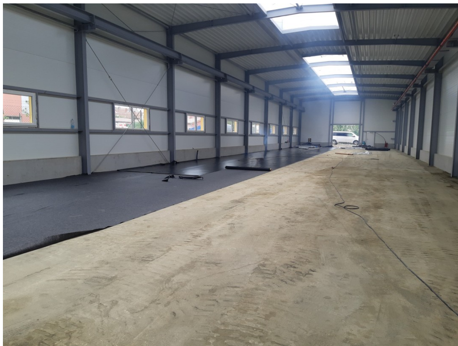
Obr. 10. Pokládání geotextílie a hydroizolace [27]
