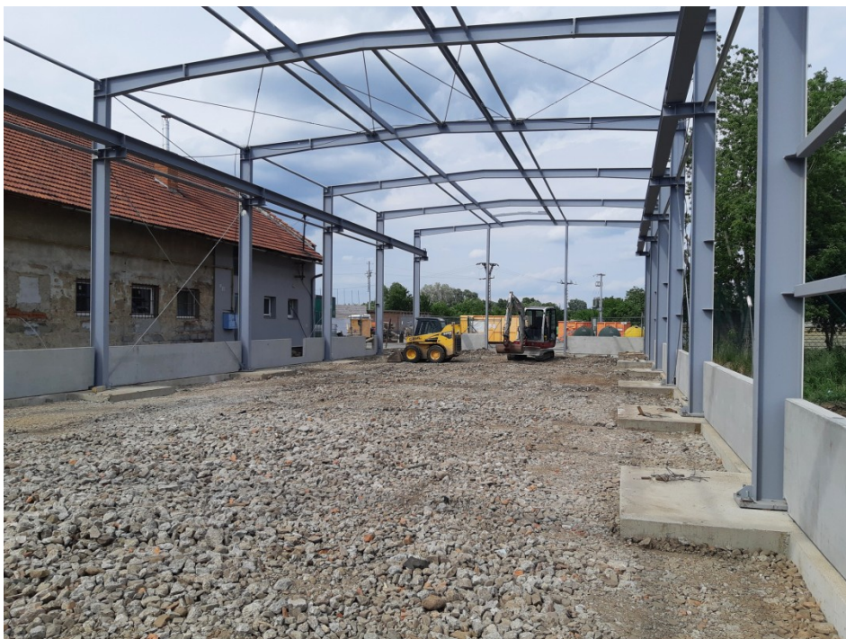
Obr. 6. Ocelová konstrukce s monolitickými základovými nosníky [27]
