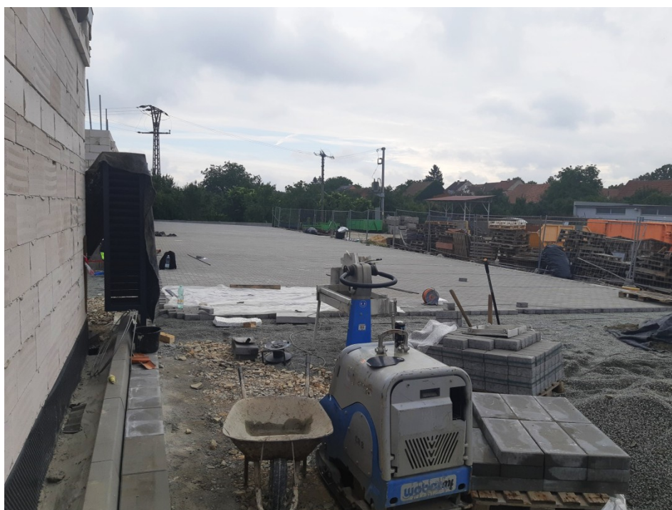
Obr. 12. Provádění parkoviště a manipulační plochy [27]
