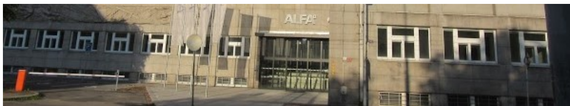
Obrázek 13: Vstup do objektu [45]
