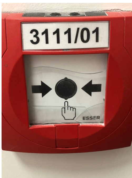
Obr. 7. Manuální tlačítkový hlásič EPS [vlastní]
