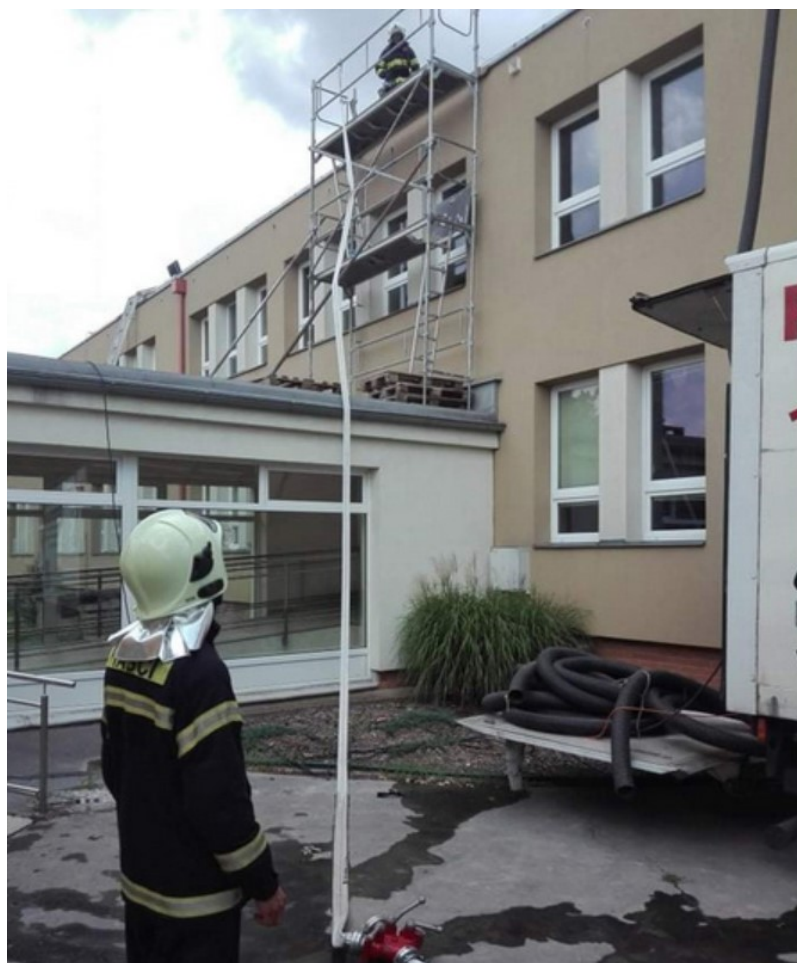
Obrázek 21 - Střecha základní školy (SDH Uherský Brod)
