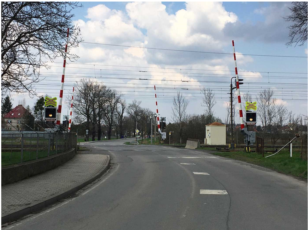
Železniční přejezd před ŽST Studénka (zdroj: autor)
