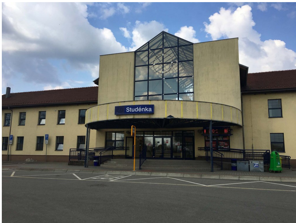
Nádražní budova (zdroj: autor)
