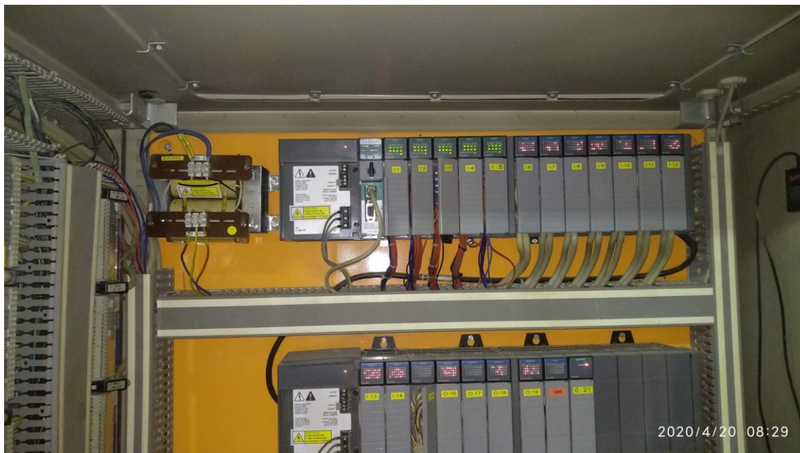
Obr. 18 SLC 5/05 – automat od firmy Rockwell Automation, uvedený na trh v roce 1991
