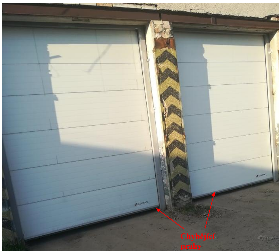
Obrázek 4 Garážová vrata skladu č. 1 (Foto autor)
