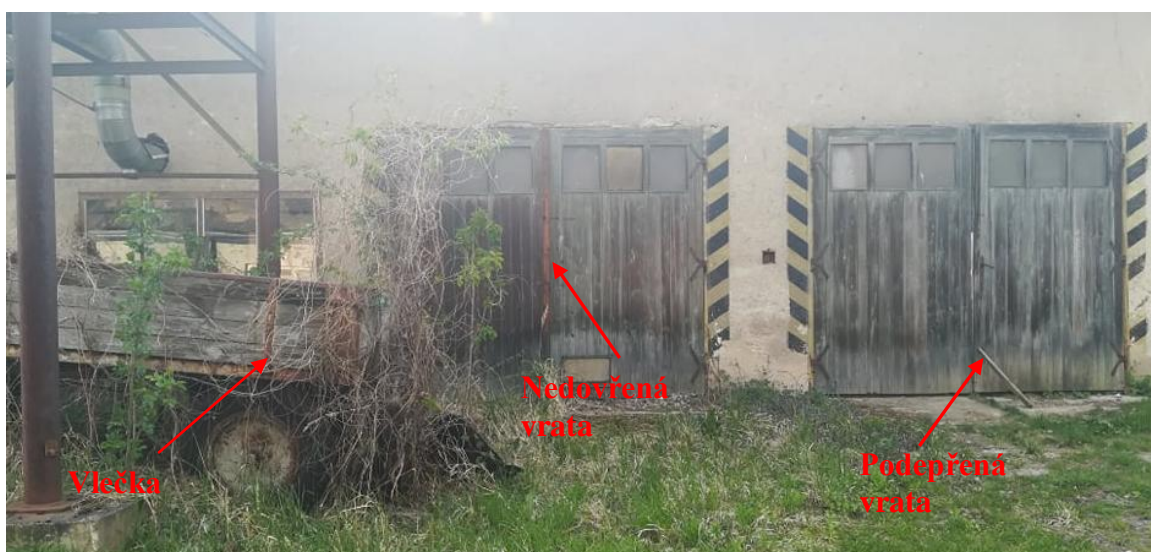
Obrázek 2 Dřevěná vrata ze zadní části skladu č. 1 (Foto autor)
