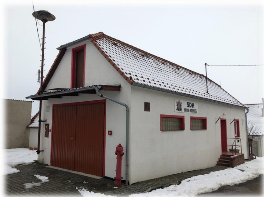
Obrázek 4 – Požární zbrojnice (zdroj:vlastní)
