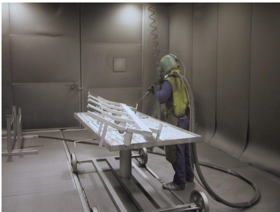
Obr 12. Pískování ocelovou drtí v boxu (Interní informace)
