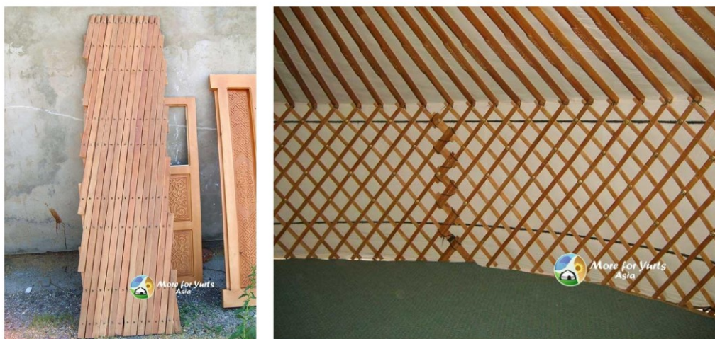
Obrázek 21. Mřížkový panel jurty, složený/roztažený stav
