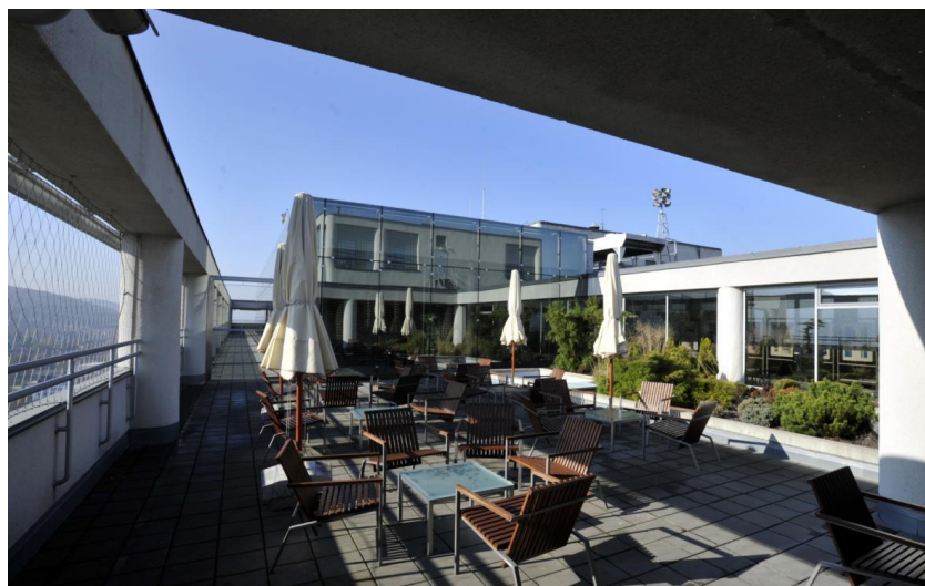
Obrázek 9. Střešní terasa Správní budovy č. 21 - současný stav
