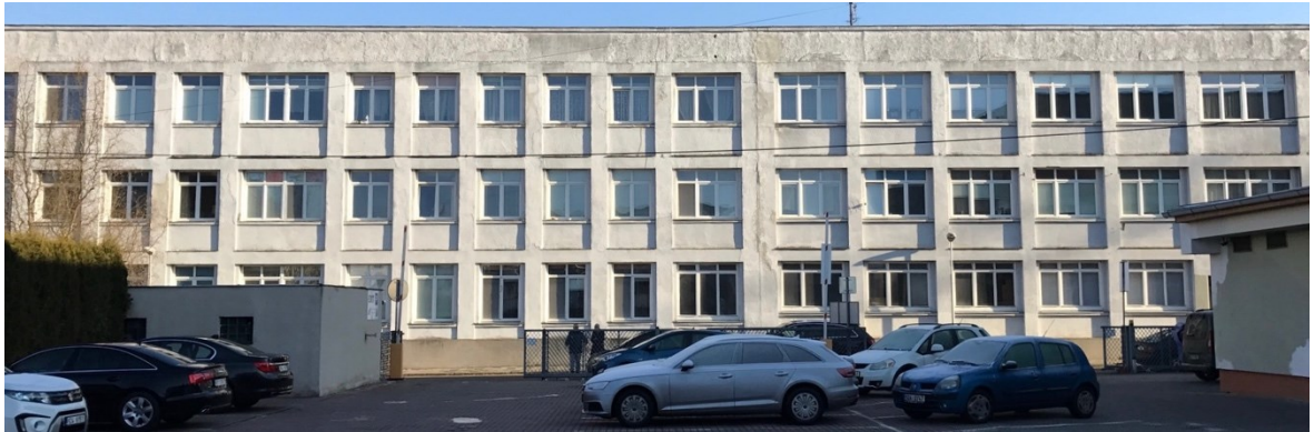
Obr. 24. Exteriér bytového domu Lešetín, stávající stav
