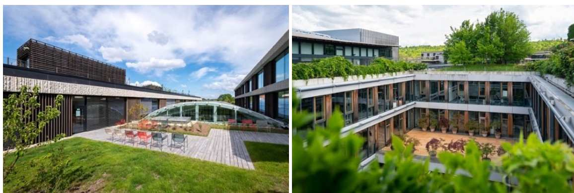
Obr. 14. Budova centrály ČSOB v Radlicích
