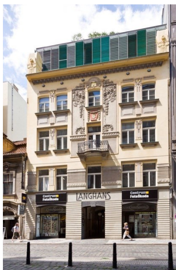
Obr. 5. Nástavba paláce Langhans
