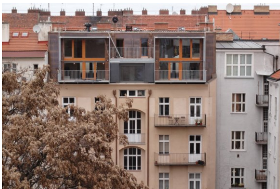
Obr. 4. Nástavba bytového domu Jaselská
