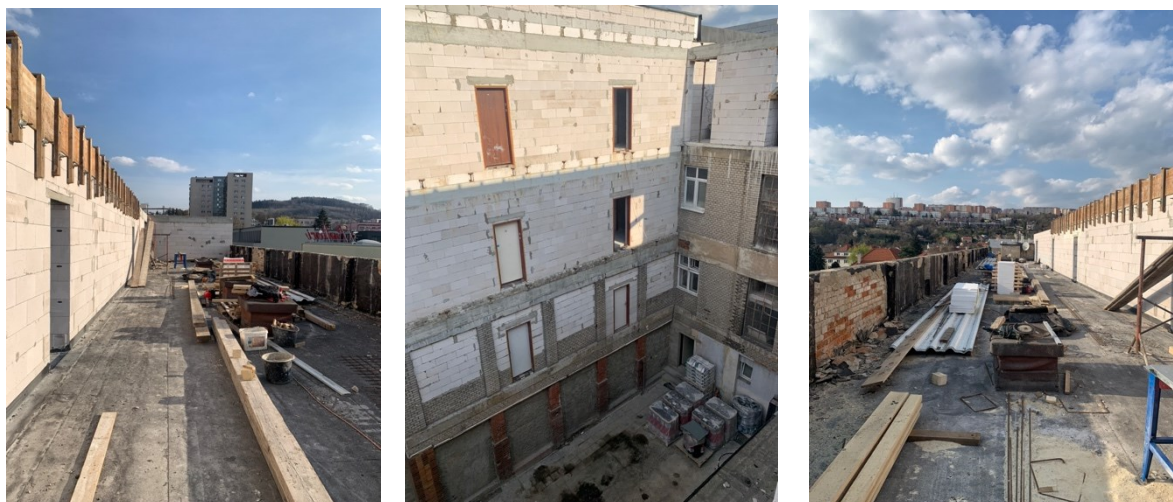
Obr. 27. Průběh rekonstrukce bytového domu Lešetín
